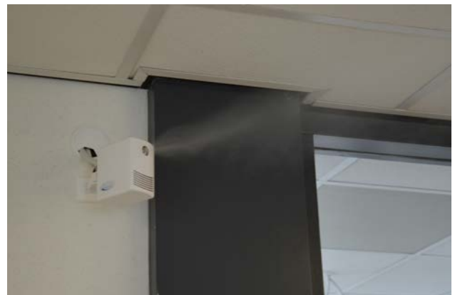
▲ In de hallen zijn de NanoFog units strategisch geplaatst voor een optimaal bereik
