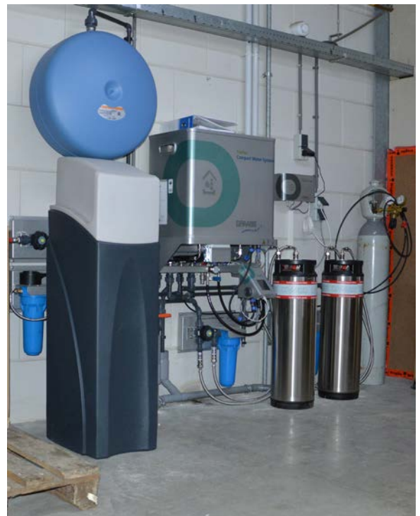
▲ De Draabe pomp en aansturing in de technische ruimte van het pand geïnstalleerd
